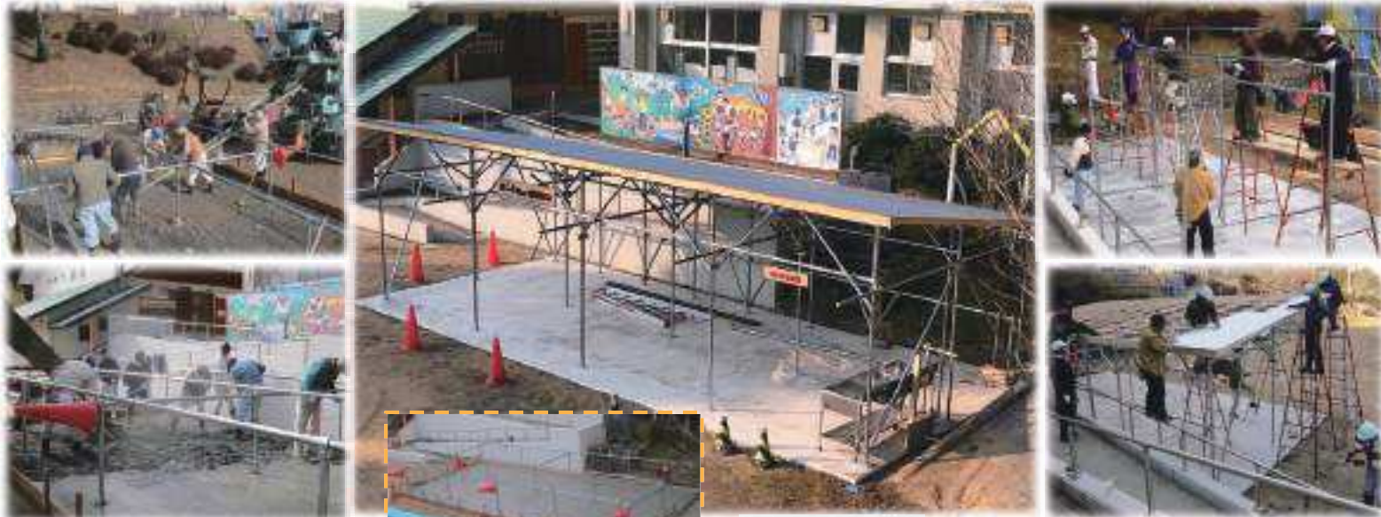
土間コン打設完了
