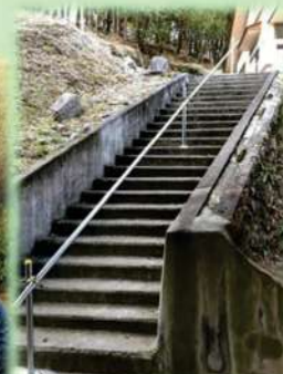
外階段に要望されていた手摺を設置
